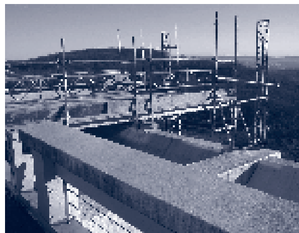
Beginn der Bauarbeiten an der Mensa der Ruhr-Uni Bochum. Dauer der Kernsanierung: Zweieinhalb Jahre
