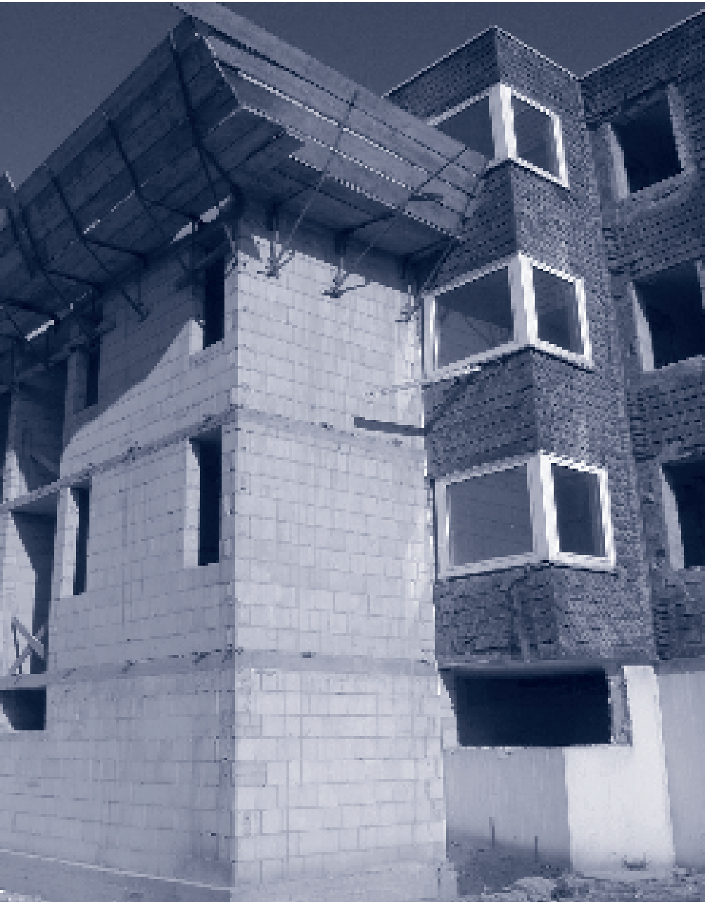
Anbau am Wohnheim Eulenbaumstraße, dadurch entstanden 114 neue individuell zugeschnittene Zimmer.
